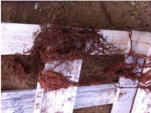
Wurzelwerk verstopfte unsere Abwasserkanäle
